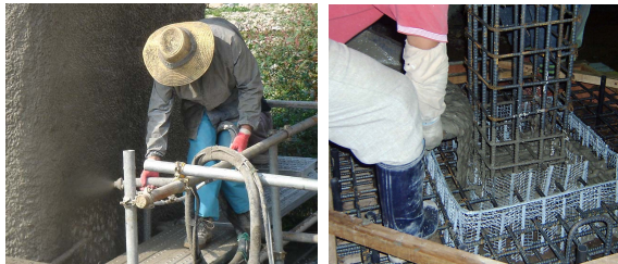
Fig. 8 스프레이 재료(좌)와 자기충전 재료(우)를 이용한 현장 시공.
